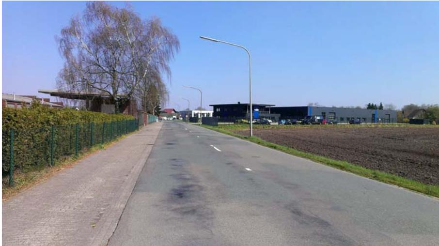
Im Kielweg sollte über eine flächenhafte Belagsverbesserung nachgedacht werden, da die vorhandenen Straßenzüge nach und nach erweitert wurden und generell unterschiedliche Querschnitte und entsprechende Alterszustände aufweisen.
