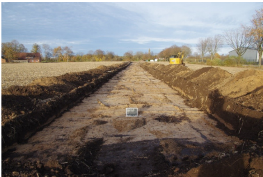
Foto: SG 1, Ansicht von SSW.
