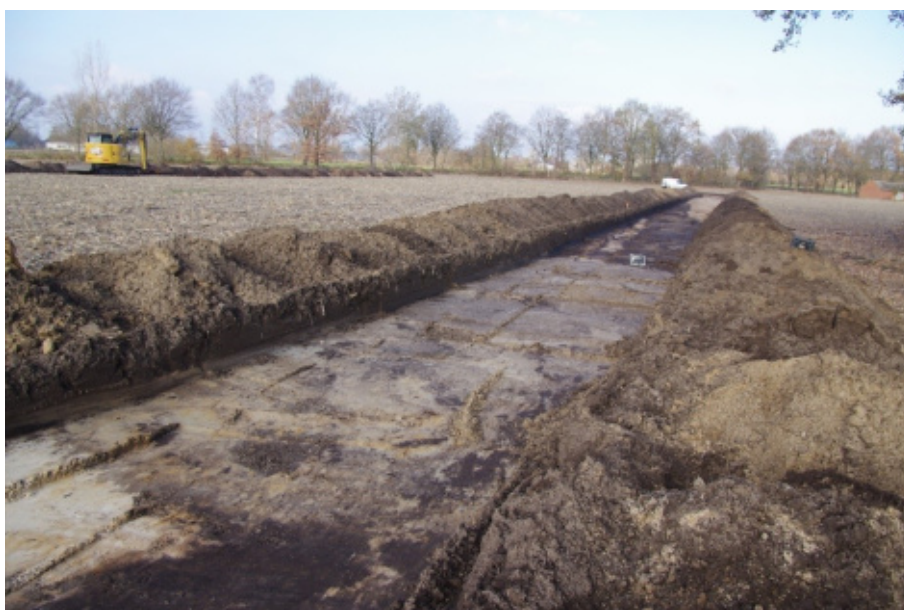
Foto: Störungen in SG 5, Ansicht von S.
