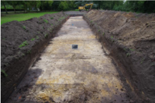
SG 1 südlicher Abschnitt
