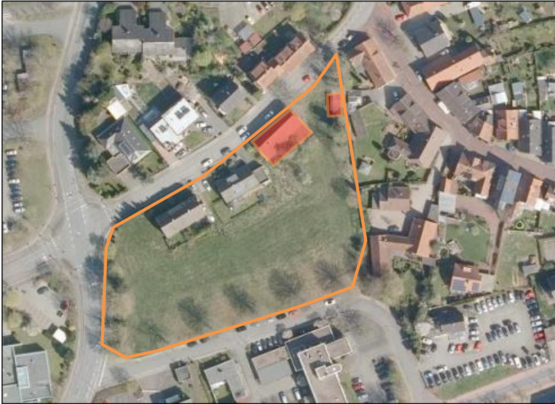
Abbildung 2: Das Plangebiet (rot: abgerissene Gebäude, https://www.umweltkarten-niedersachsen.de aufgerufen am 13.03.2024)
